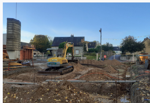
Les fondations sont posées
